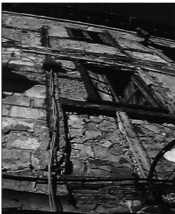
Figura 4. Detalle de la fachada principal
