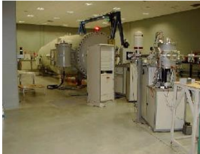
Figura 2.13. Nave del acelerador del CMAM y cámara de vacío
