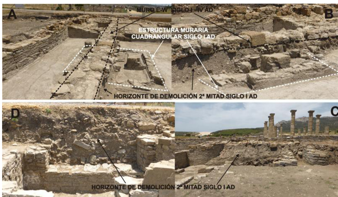
Fig. 5.—Relaciones espaciales entre estructuras murarias de la primera fase de la ciudad ( \leq Siglo I), segunda fase (Siglo I – Siglo IV) y el horizonte de demolición de la segunda mitad del siglo I. A) Relaciones de corte de estructuras murarias al Este de la plaza de la Basílica. B) Vista de las mismas estructuras desde el Sur, en la que se observa el horizonte de demolición intermedio. Obsérvese el importante reciclaje de sillares, tambores de columnas, etc., que aparecen en la reconstrucción de la ciudad sobre el horizonte de demolición. C) Vista general del horizonte de demolición estructuras amortizadas del siglo I bajo la zona de la Basílica (columnas al fondo). D) Vista de detalle del horizonte de demolición ilustrando las características de los rellenos antrópicos en una antigua puerta de acceso a una vivienda.
