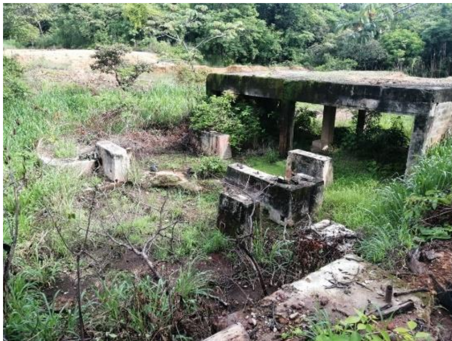
2. Ruinas de la planta de proceso.
