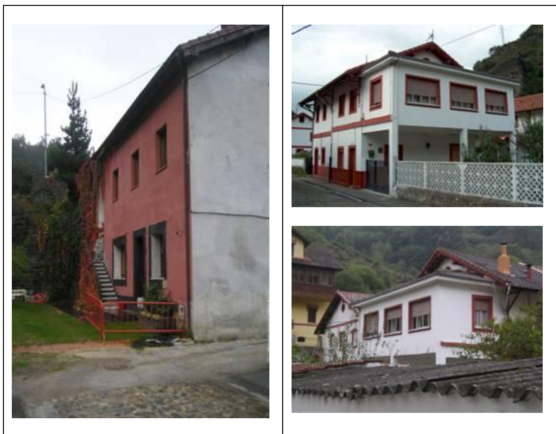
Figura 4. Cambios estructurales producidos en las viviendas
