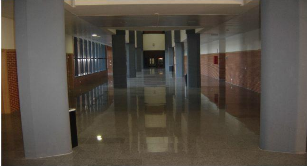
Figura 4-3: Vista frontal del pasillo de la planta baja del edificio C de la EPS
