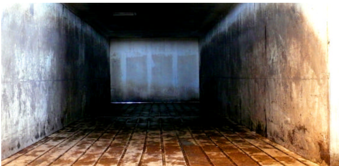
Figura 7. Túnel de aireación forzada para compostaje de materia orgánica.
