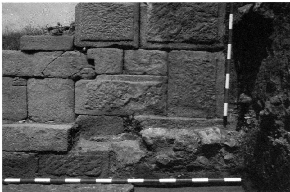
Lámina 3. Detalle del muro púnico del 2.º momento de la ciudad
