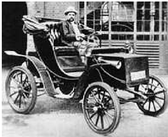
Figura 1.6. Vehículo eléctrico de 1900 propulsado por una batería de níquel – hierro.
