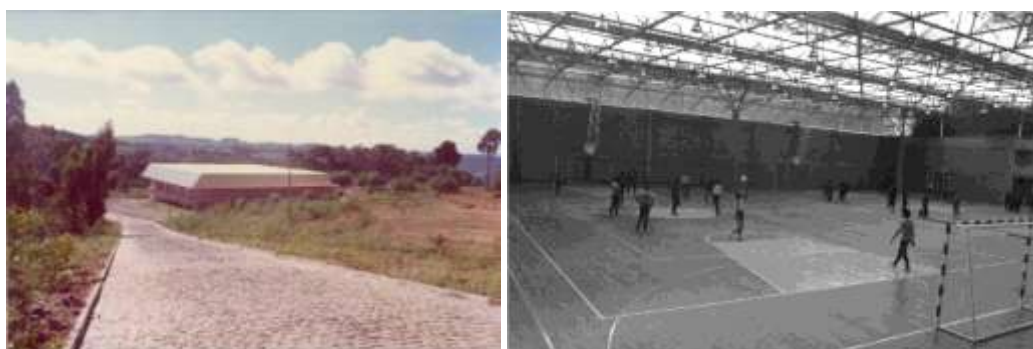
Imágenes de Pabellón Deportivo da la Universidad de Caxias do Sul, en el año 1980. Fotografías pertenecientes al fondo del Departamento de Educación Física da la Universidade de Caxias do Sul .
