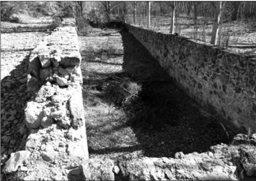
Figura 2. Vista del caz aguas arriba
