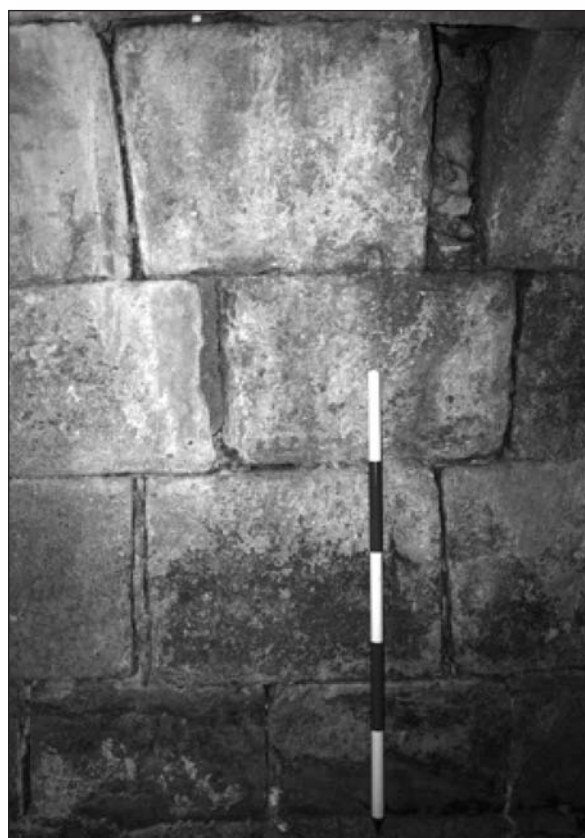
Figura 14. .- Detalle de paramento del cárcavo sur.
