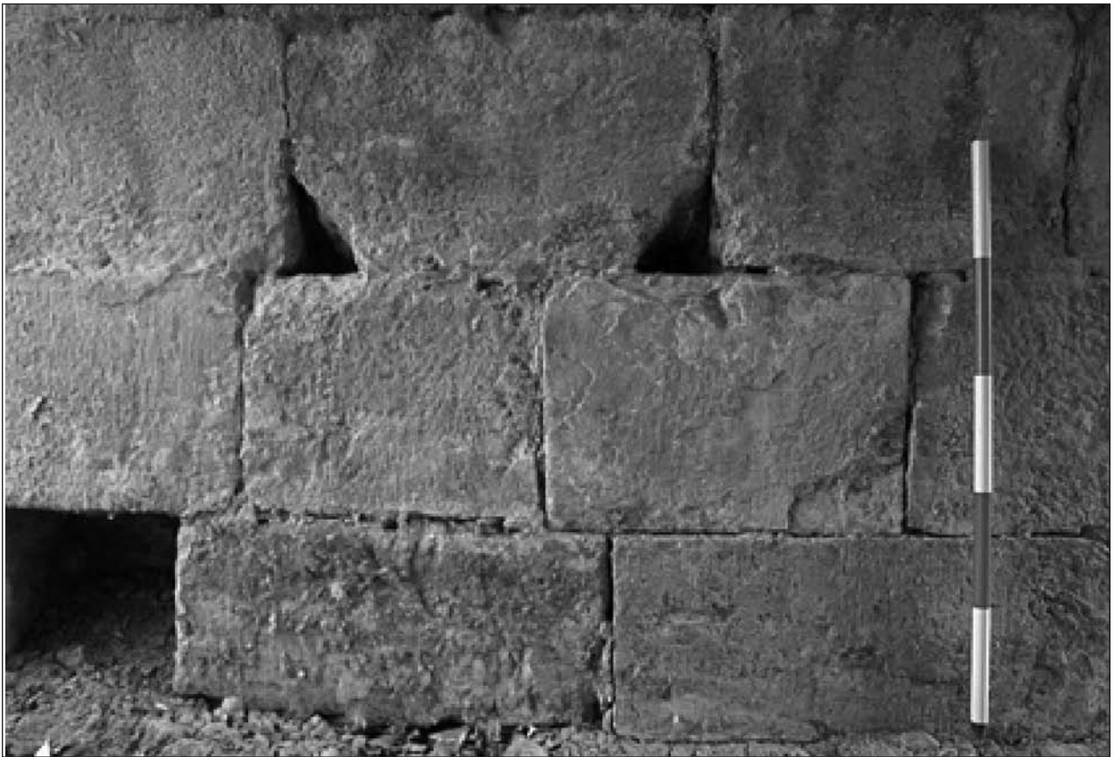
Figura 10. Detalle de paramento en cárcavo norte.
