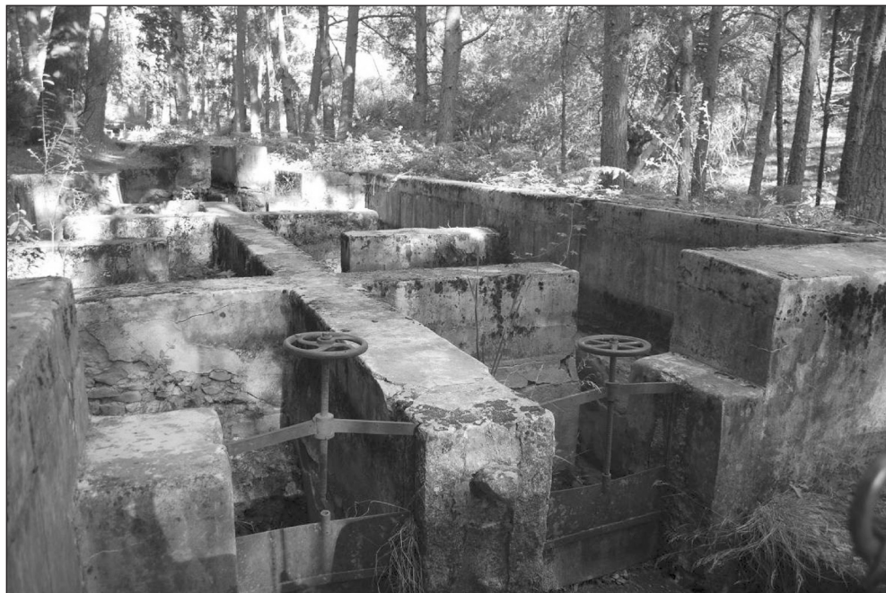
El azud del acueducto
