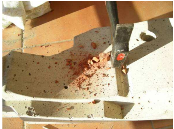
Fig 5. Proceso de machaqueo de la teja sobre piedra
