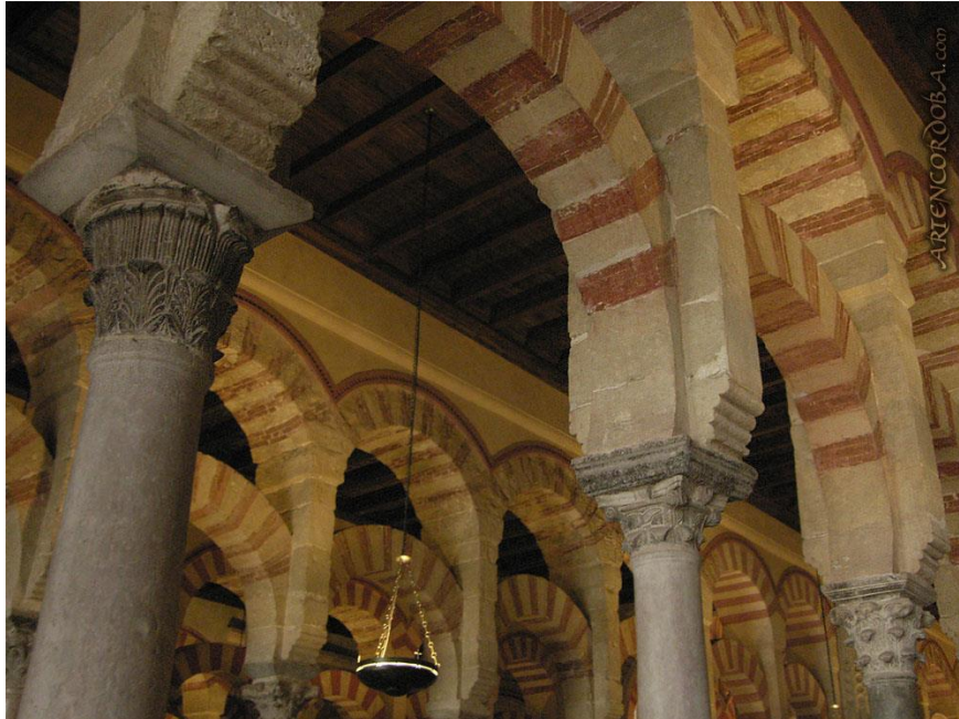
Fig. 54. Detalle de columnas, capiteles y cimacios reutilizados en la primitiva mezquita construida por 'Abd al-Rahmān I.
