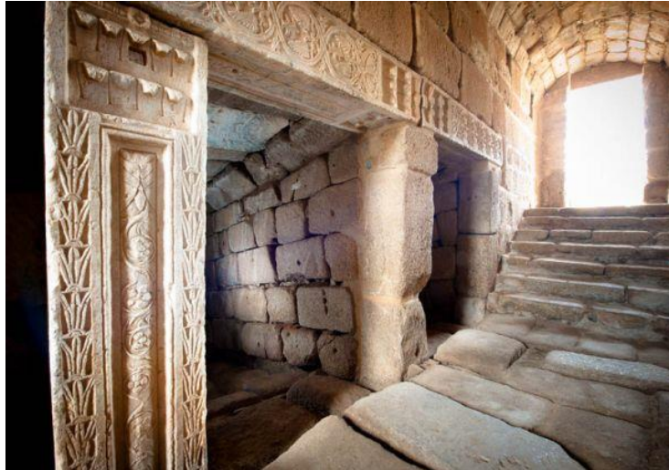
Figs. 45-6. Piezas reutilizadas en el Aljibe de Mérida. Vista exterior e interior tras la reconstrucción realizada.
