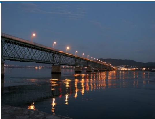
Puente Eiffel. Portugal
