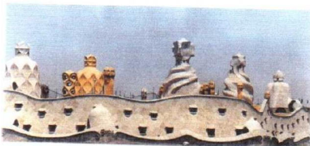
Figura 212: Marca M-2608903, Detalle de la parte superior de la fachada de la Pedrera edificio modernista y singular del arquitecto Antonio Gaudí, ubicada en Barcelona, cl. 2, 3, 6, 8, 14, 16, 17, 18, 21, 25, 28, 29, 30, 32, 33, 34, 35, 36, 37, 38, 39, 41 y 43, a nombre de la FUNDACIÓ CATALUNYA-LA PEDRERA, FUNDACIÓ ESPECIAL.
