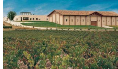
Figura 12: Bodegas Marco Real en Olite (Navarra) Arquitecto Francisco Mangado Foto: www.asegarce.com
