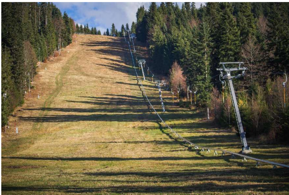
Figura 41. Instalaciones de la estación de deporte invernal de Navacerrada. Madrid.
