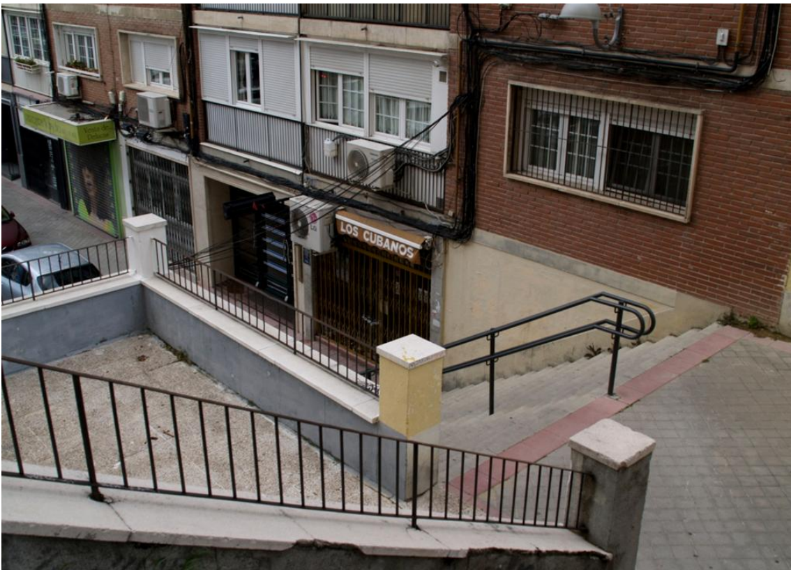
Foto I. 18. Escaleras sin rampa, El Pilar (2ª fase). Fuente: S. Garrido, abril de 2021
