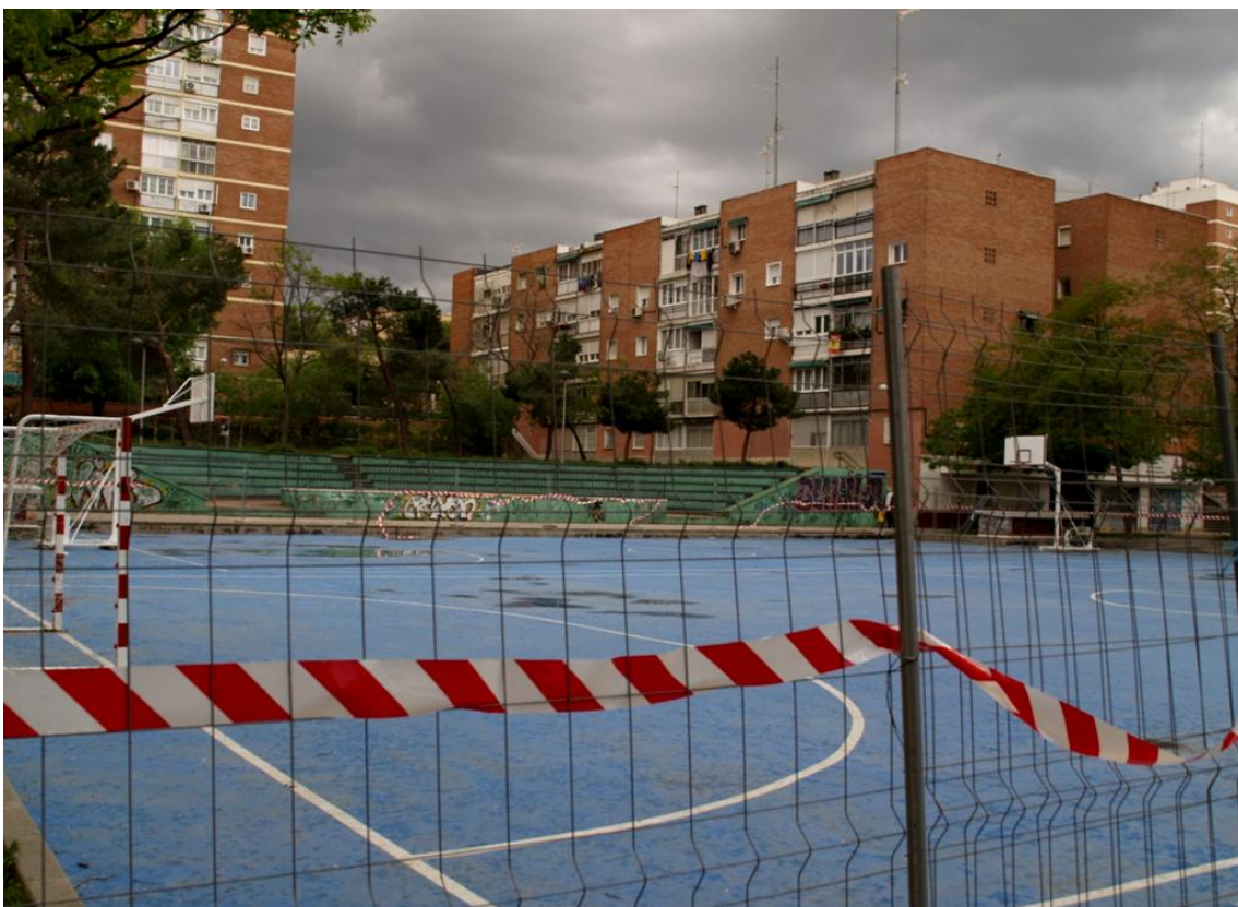
Foto I. 20. Pistas deportivas deterioradas y sin mantenimiento. Fuente: S. Garrido, abril de 2021
