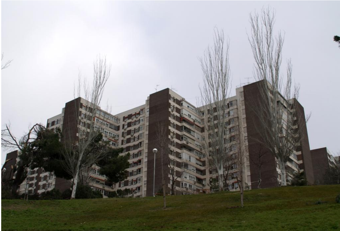
Foto I. 3. Conjunto Residencial Altamira. Fuente: S. Garrido, enero de 2021
