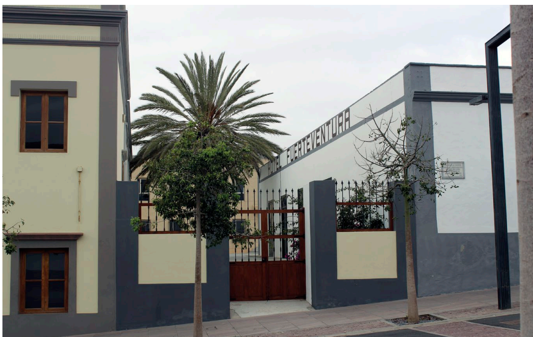
Figura 3.12. Detalle de la fachada este del inmueble. © Foto G. de Santa Ana (2020)
