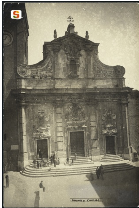
“Duomo di Cagliari”, Cagliari, 1905 ca., Collezione Colombini. http://www.sardegna.digitallibrary.it/index.php?xsl=2436&id=35451 (última consulta 20 de enero de 2022). Esta fachada barroca se terminó de construir en los primeros años del siglo XVIII, aunque está dentro de la dinámica de remodelación de la catedral que se inició en el siglo XVII y cuyo actor principal fue el arzobispo Pedro de Vico.
