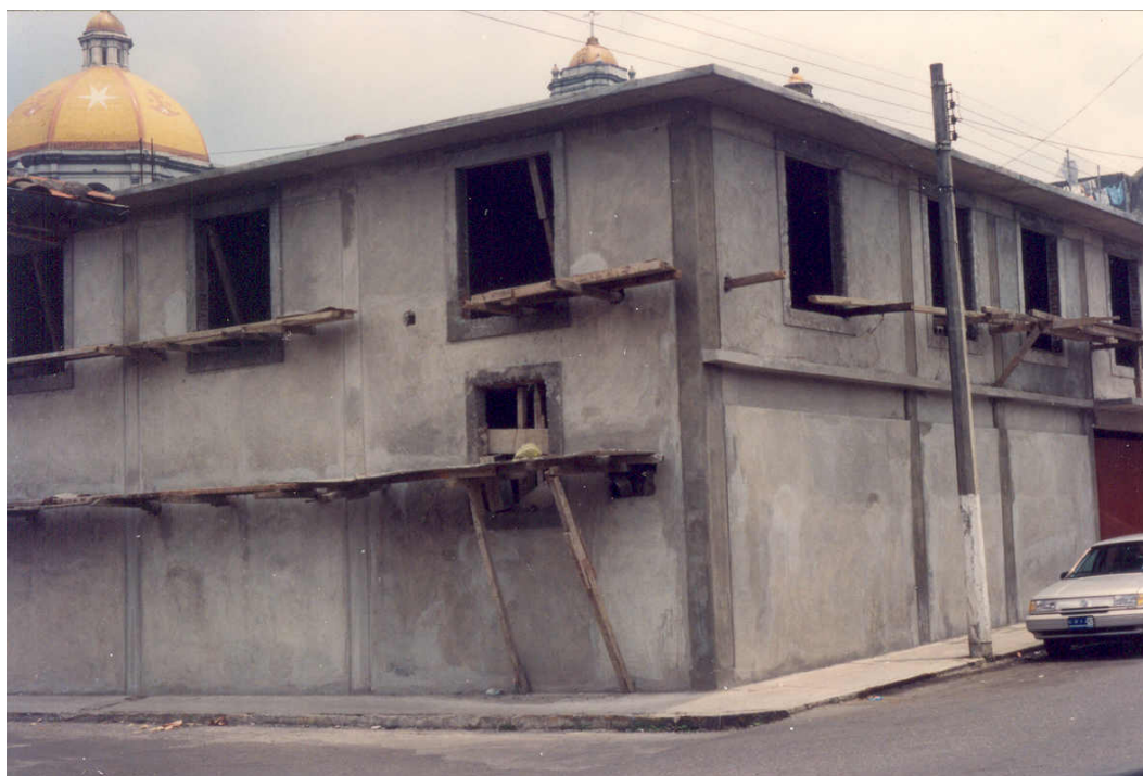
Trabajo de construcción del nuevo edificio de la Casa de Cultura 400
