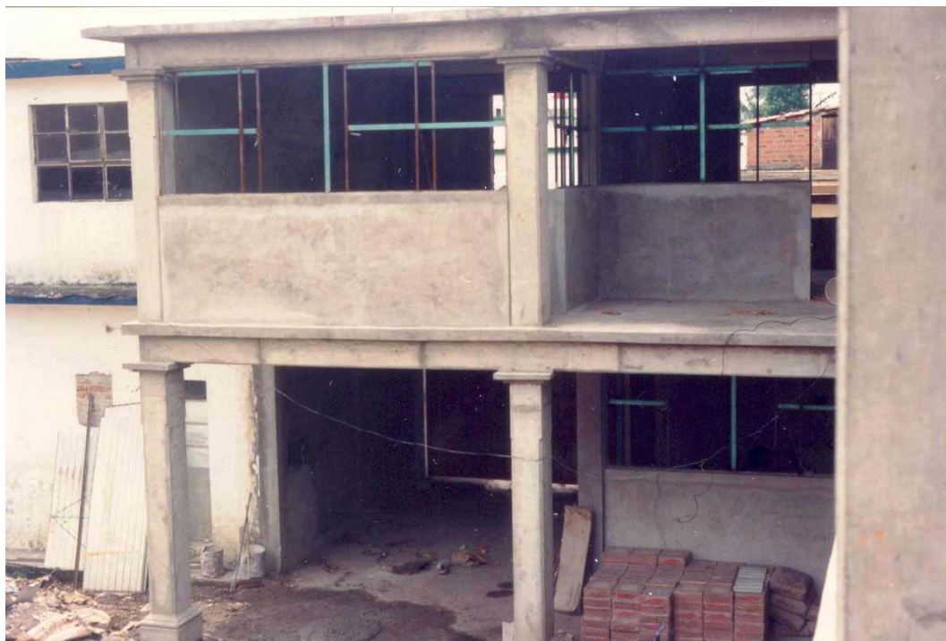
Trabajo de construcción del nuevo edificio de la Casa de Cultura 401
