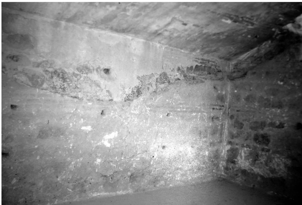
Fig. 2 – Interior del aestivus locus . Detalle del muro y bóveda.
