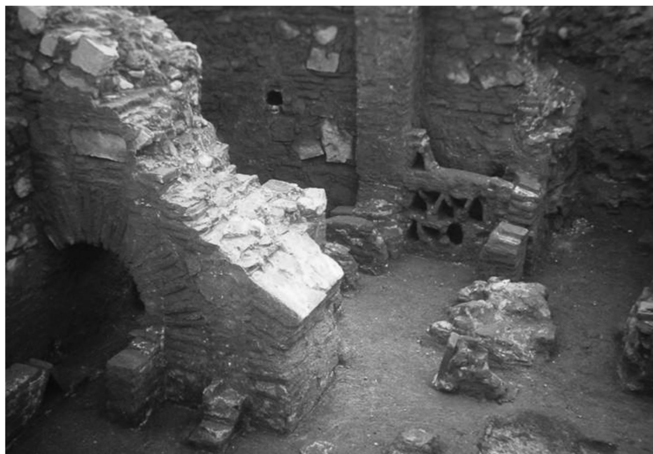
Fig. 4 – Termas de la vivienda del siglo IV. Detalle de la construcción tipo panelado realizado en el hipocaustum .
