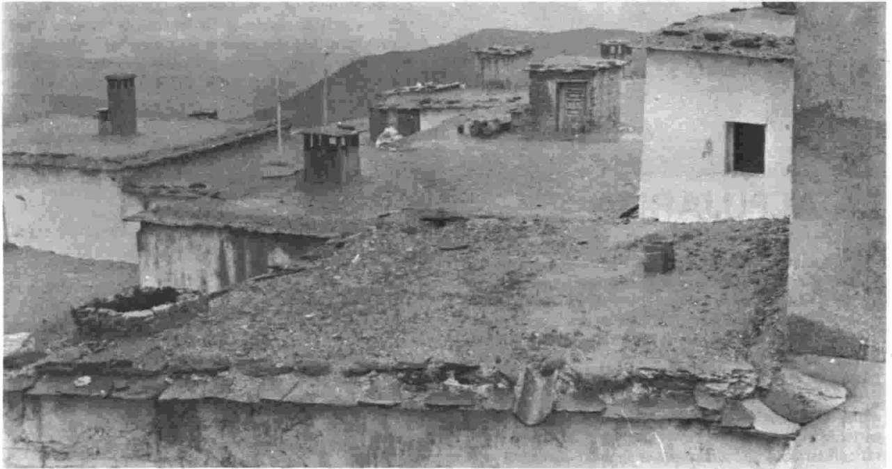
Terrados cubiertos de launa.
