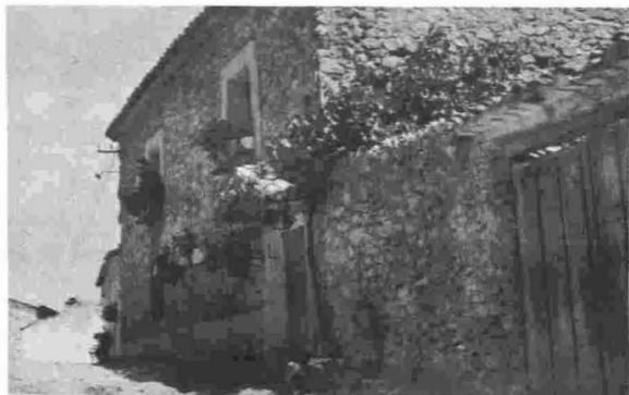
Valdecolmenas de Arriba, Cuenca (Alcarria), con presencia del tejadillo
