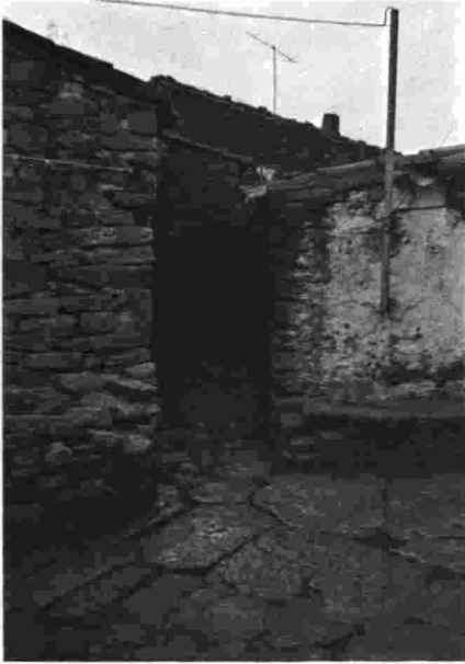
3. Pavimentación de las calles con losas de piedra. Villar de Peralonso.
