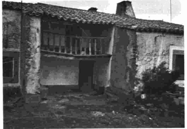
5. Zafrón: casa de dos plantas con muretes de protección en la fachada.
