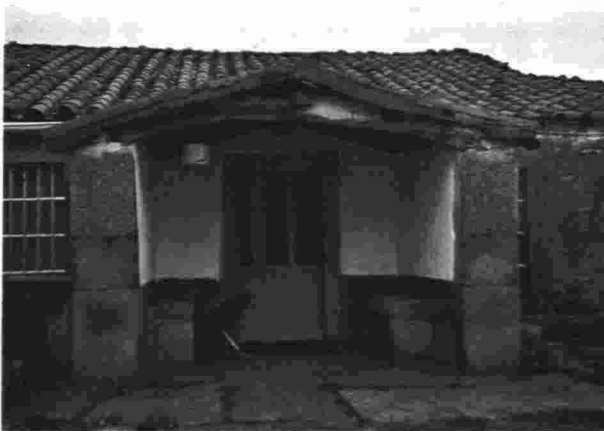
4. Villar de Peralonso: fachada de una casa con muretes de protección.
