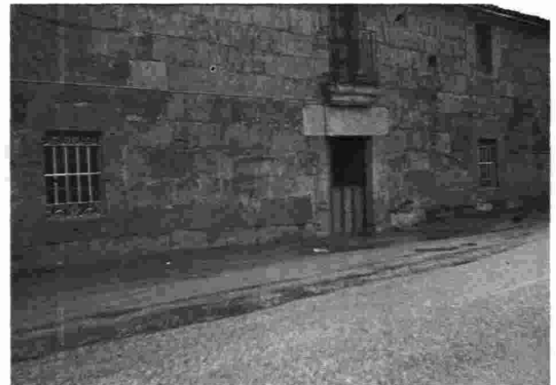
2. Valverdón: casa construida en sillares.
