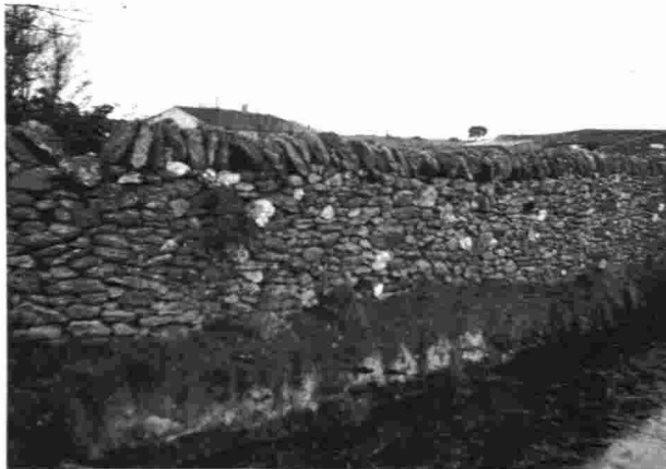
1. Doñinos de Ledesma: construcción de tapias de granito con cuarzo intercalado.
