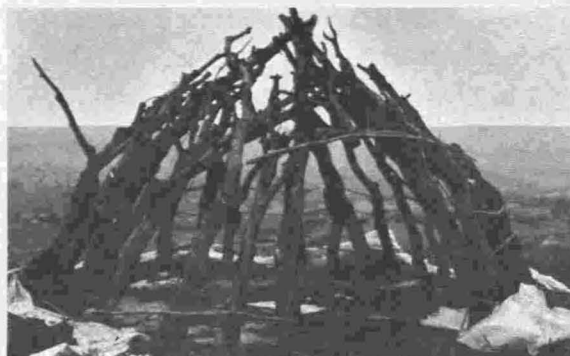
Foto 1: Armazón de troncos para formar el chozo de paja de centeno de el Casar de Cáceres próximo a la ermita de San Benito.
