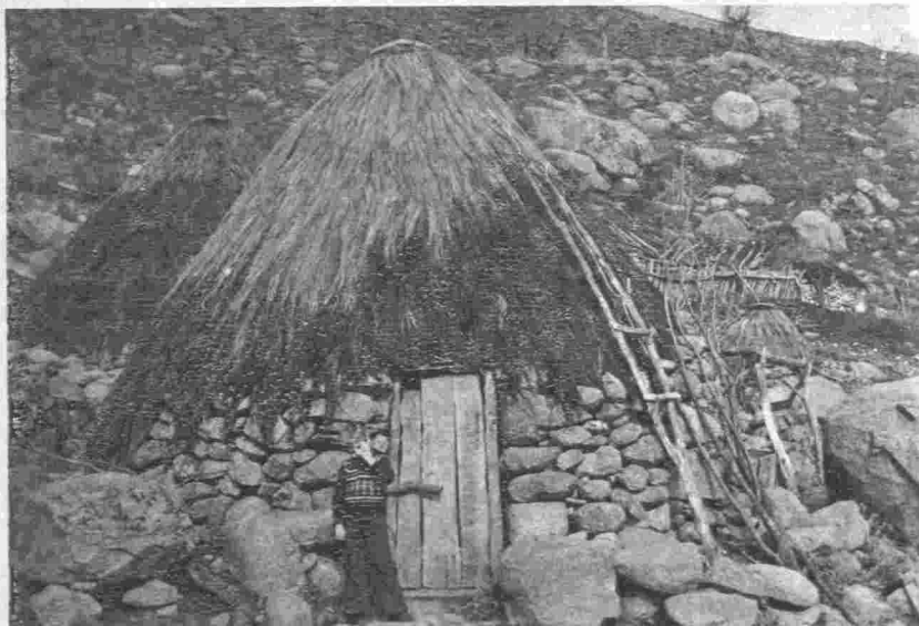
Foto N°3 Almacén como depósito de pensos.
