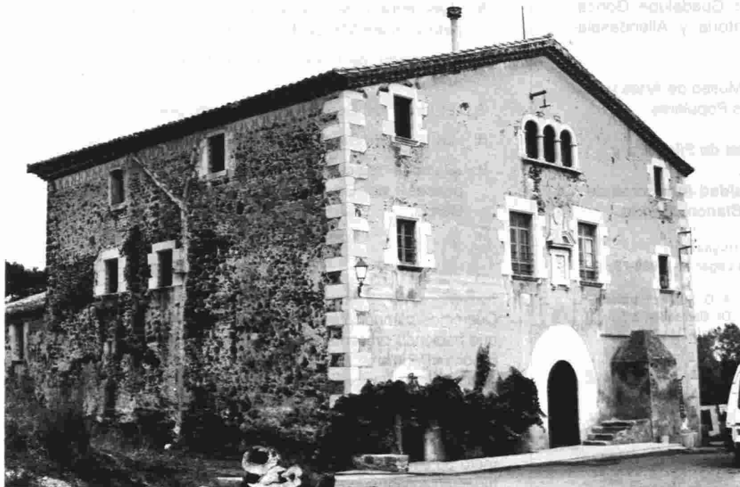
Can Cavallé. Fachada. Estanyol.
