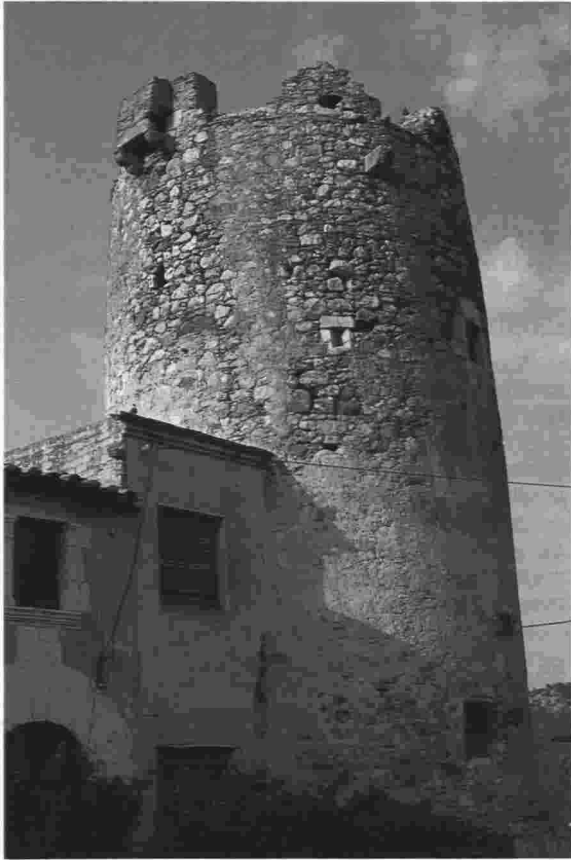
Torre castillo de Torroella de Montgri. Bajo Ampurdán.
