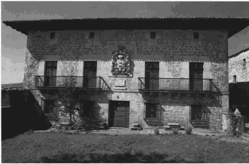
Palacio rural Verástegui en Manurga (Llanada Alavesa). Foto: Victorino Palacios.
