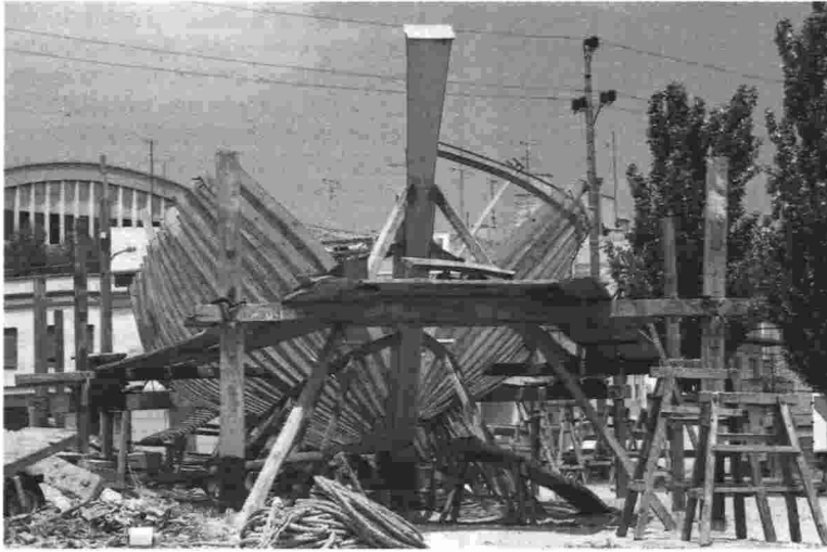
Ensamblaje de las cuadernas. Dan forma al barco. (Foto: Paco Cabanes.)
