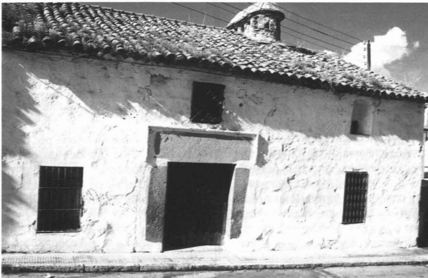
Pozoblanco. Calle Pozo Viejo. «Casa de la Viga».
