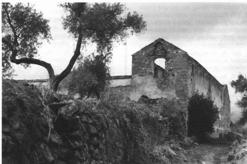
Fig. 1. Restos de un molino. Montoro.
