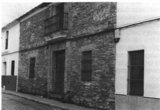
Casa de Puebla de Guzmán en fase de restauración, mostrando el tipo de arquitectura popular a base de lajas de pizarra y vanos enmarcados por ladrillos. (Foto: J. P. Garrido.)
