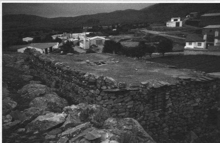
Balates y rampas de subida a una era y pajares al fondo. Eras de la Ermita en Huéneja.
