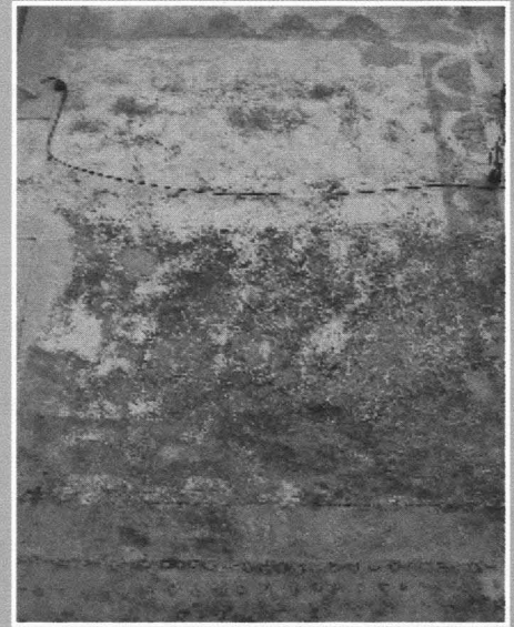
Fig. 8: Pintura de Fachada. C/. Plaça 1 (Valdemossa). Panel Derecho.
