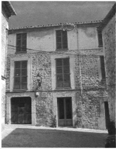
Fig. 7: Fachada en la que se combina el revestimiento de piedra y el enjabelgado.
