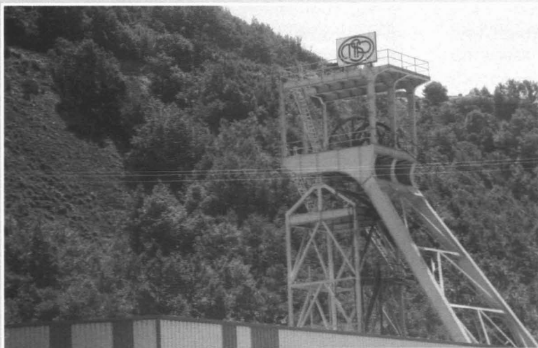
Ascensor de entrada a la Mina Feisolín, Orallo
