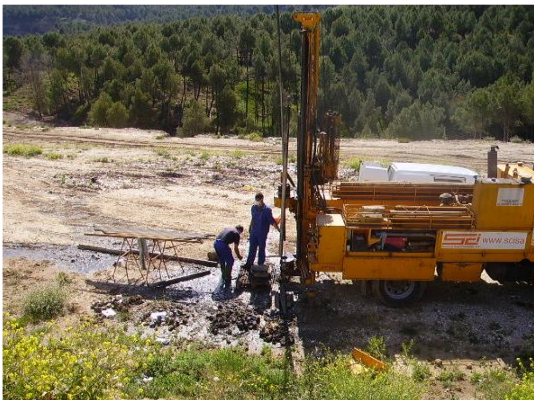
Foto 2.4 Máquina de sondeos en vertedero Z6V1.
