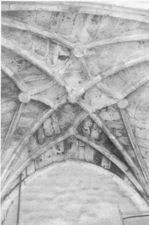
Fig. 6.- Bóveda de la Capilla del Descendimiento.
