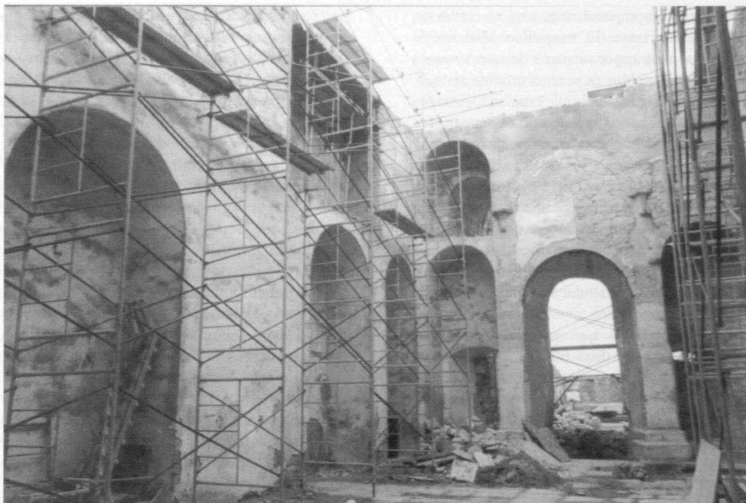
Fig. 2.- Perspectiva de la Capilla en dirección a la entrada original tras la Capilla Mayor del Monasterio. En el lado sur se distingue el doble nicho superpuesto.
