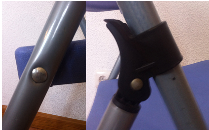
Figura 4.3: Un pivote fijo (izquierda) y un pivote deslizante (derecha) en una silla plegable
