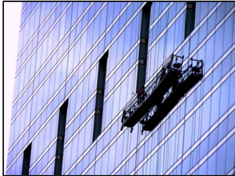
Figura 1.5 Edificio con ventanas autolimpiantes que poseen un recubrimiento de TiO 2 .
