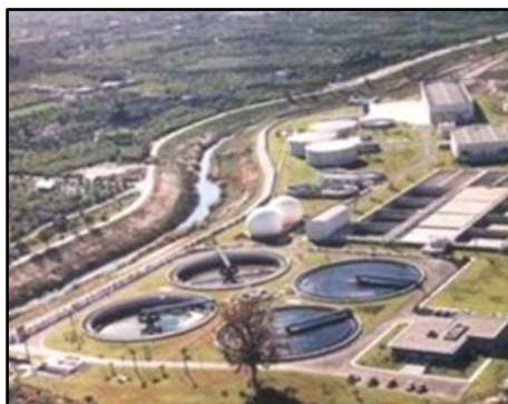
Figura 1.1 Planta depuradora de aguas residuales del Canal de Isabel II, Madrid.
