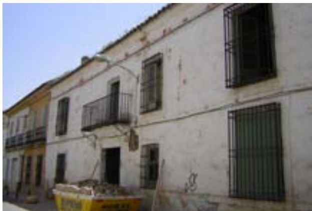
Recuperación de la fachada y patio de edificio antes de la rehabilitación.
