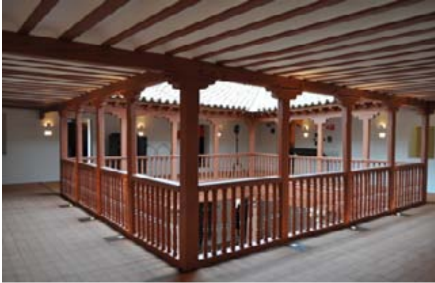
Patio interior del Museo del Hidalgo, tras la rehabilitación.
