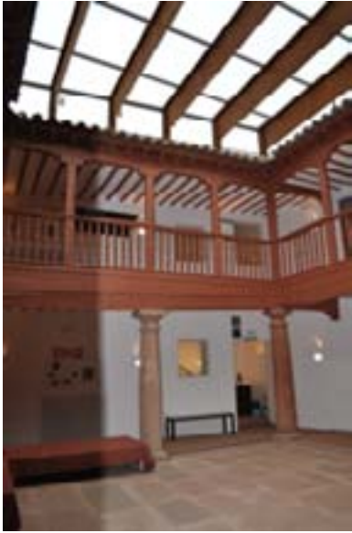
Vista de la rehabilitación del patio cubierto.
