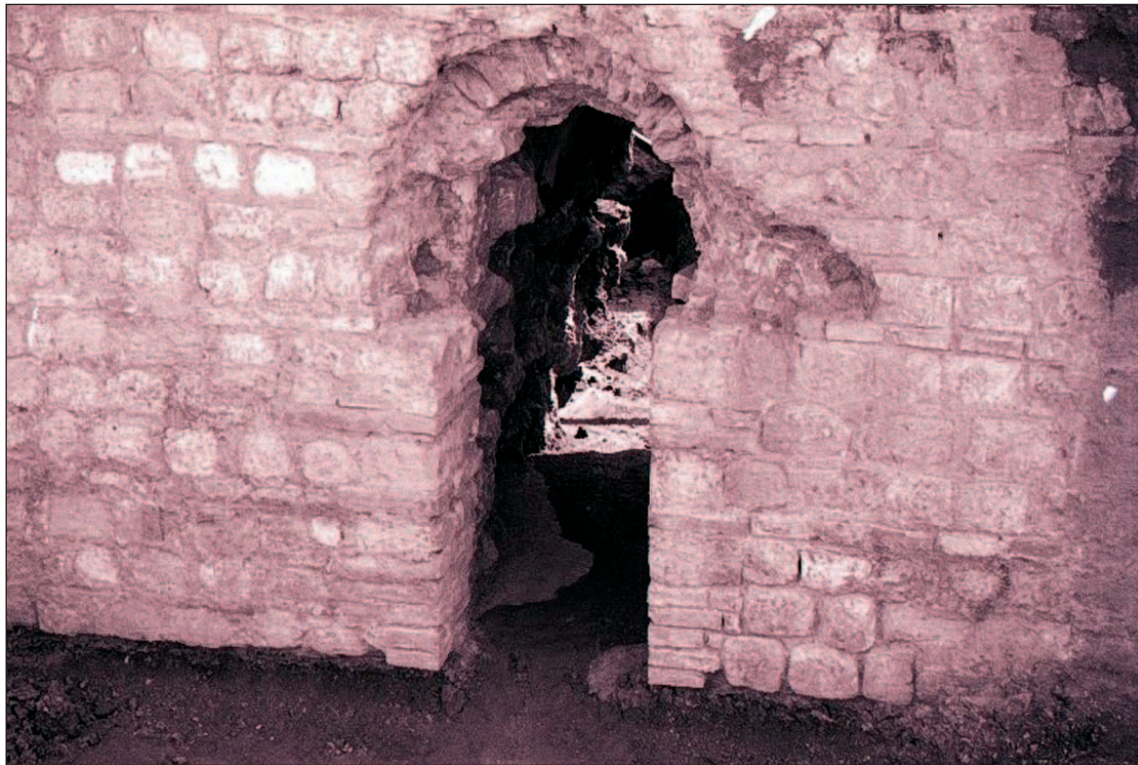
Figura 10.- Puerta del muro perimetral del criptopórtico.
