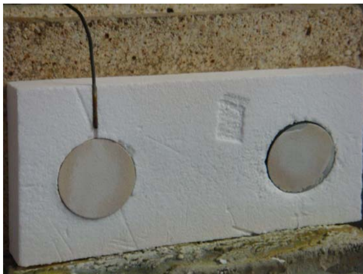
Figura 4.45. Fotografía del aspecto de los recubrimientos después del ciclado térmico.
