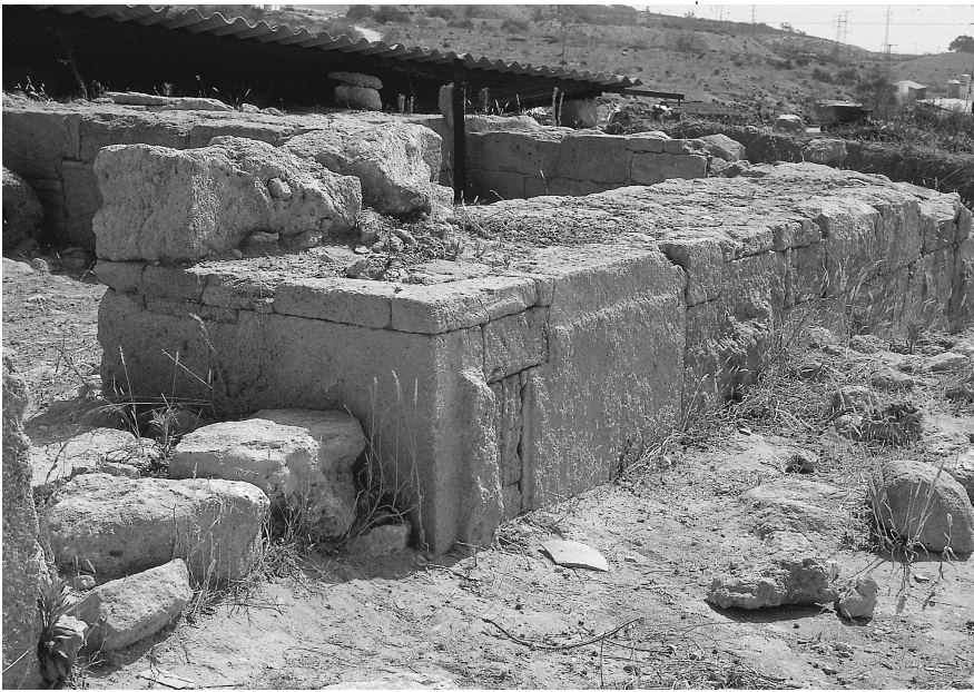
Fig. 7.- Muro púnico helenístico, de sillares con engatillados y ligero almohadillado, del Castillo de Doña Blanca.
