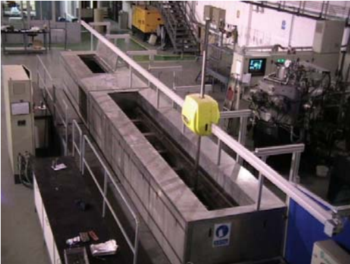
Figura 6. Vista general de una línea de limpieza industrial previa a los tratamientos mediante PVD.
