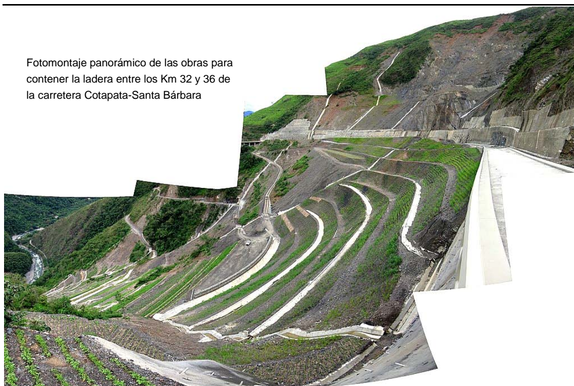
Foto 4.11 Obras de estabilización de las laderas en nueva carretera (Km 32 a 36)
