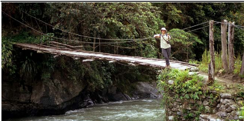
Foto 4.15 Puente sobre el río Huarinilla en la comunidad de Yucupi-Chimani
