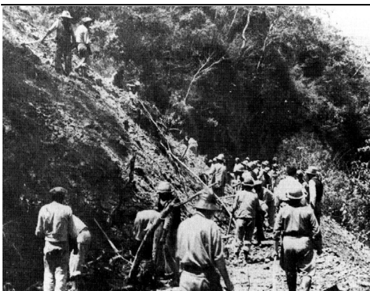
Foto 4.6 Trabajos de construcción de la carretera a Buena Tierra (1941)
