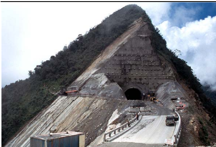
Foto 4.10 Entrada norte del túnel de San Rafael
