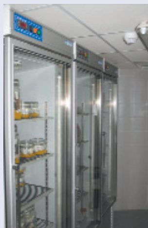
Las semillas conservadas en el BGVPA se mantienen desecadas (4-7% HR) en cámaras refrigeradas (-18° C), en recipientes con indicadores de humedad, siguiendo los protocolos estándar de conservación de semillas.
