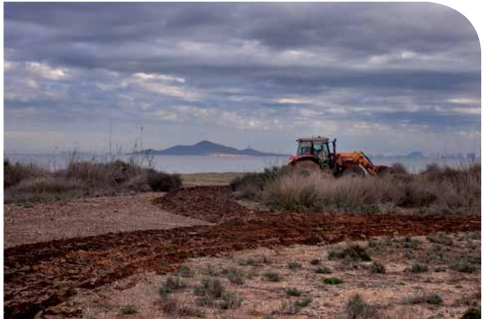
Foto 1. Tractor levantando los caminos que discurrían por el DPMT del área protegida de Lo Poyo para evitar la circulación de vehículos por los arenales. Los caminos han sido revegetados con flora dunar posteriormente.
