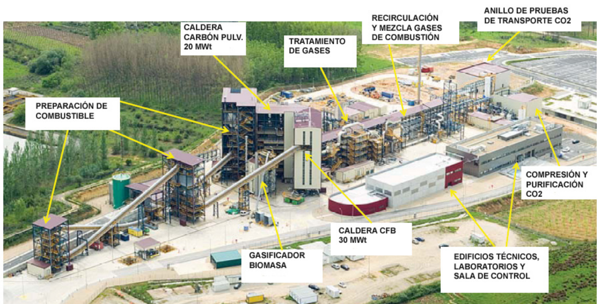
Figura 35: Fotografía y unidades principales de la planta de ensayos de captura y transporte de CO 2 (es.CO 2 ) de CIUDEN en Cubillos del Sil (León). Adaptado de [61].
