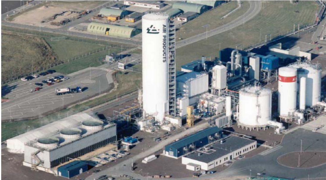
Figura 16: Planta comercial ASU con capacidad de separar 3250 tCO 2 /día [15].
