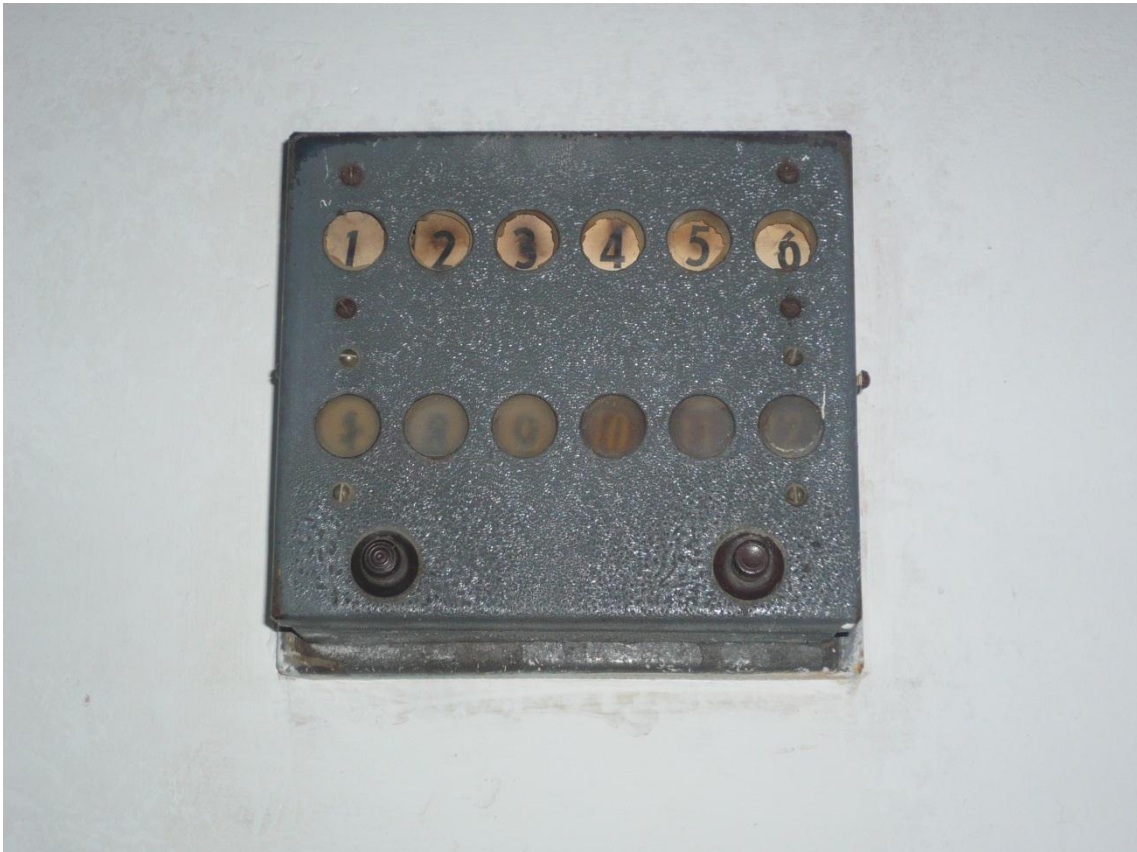
Figura 24. Timbres de llamada. Se conserva aún en la clínica el sistema de llamados de los pacientes. Cuando un paciente llamaba se encendía la luz de debajo del número de cama. Fotografía del autor.
